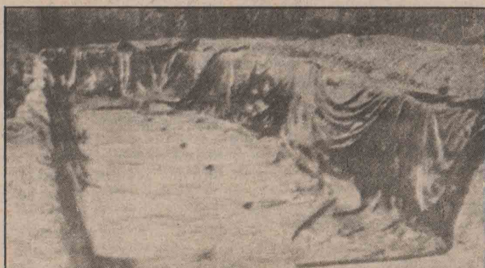
Silo trincheira Modelo revestido apenas com lona plástica
