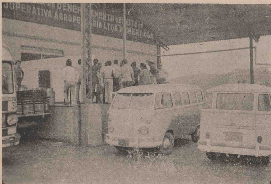
Vista parcial da fachada do Posto de resfriamento da cooperativa de Ibertioga, em Barbacena.
